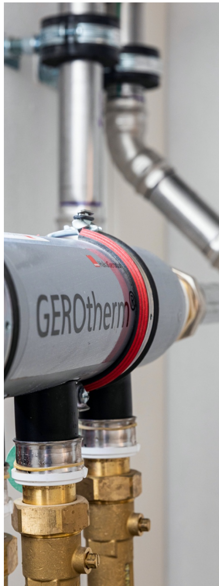
Pompe à chaleur
