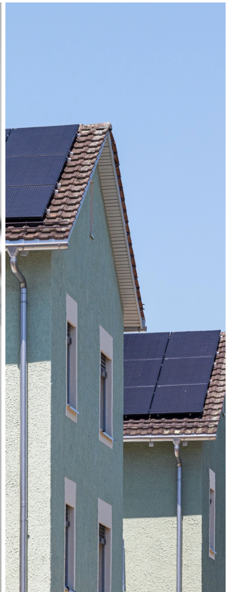
Installation photovoltaïque sur le toit
